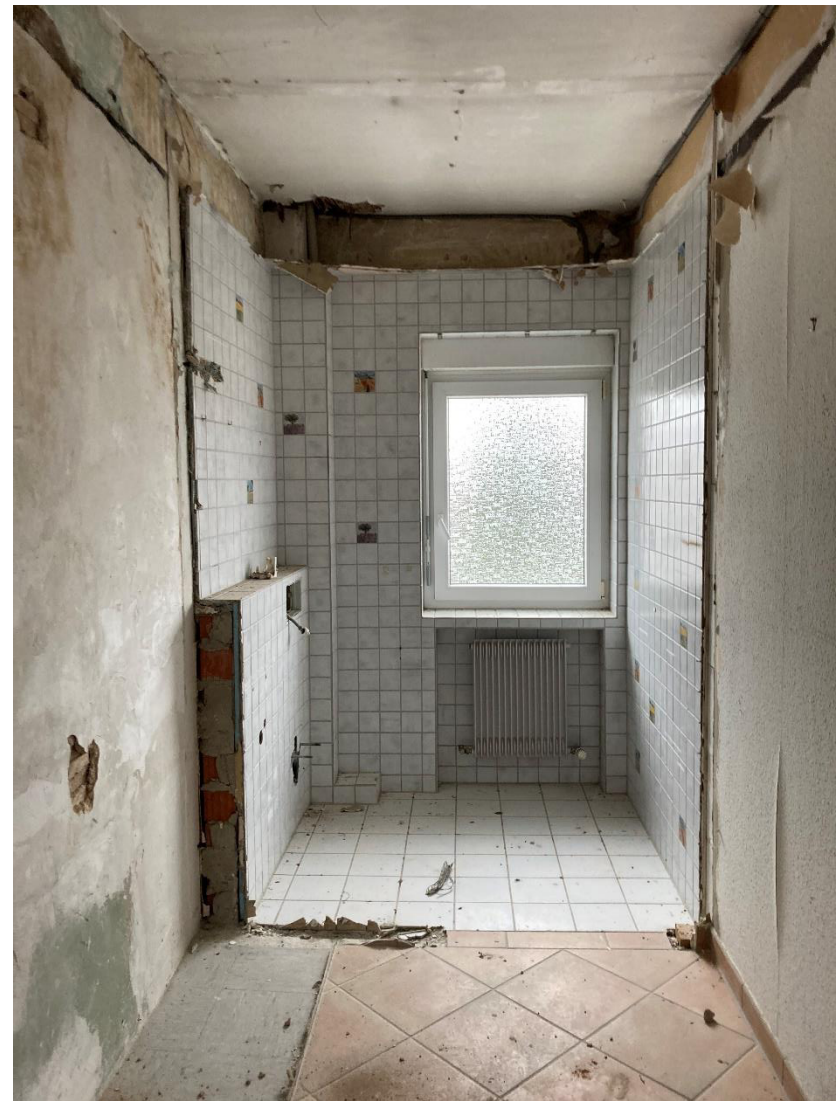
Flur in Richtung WC
