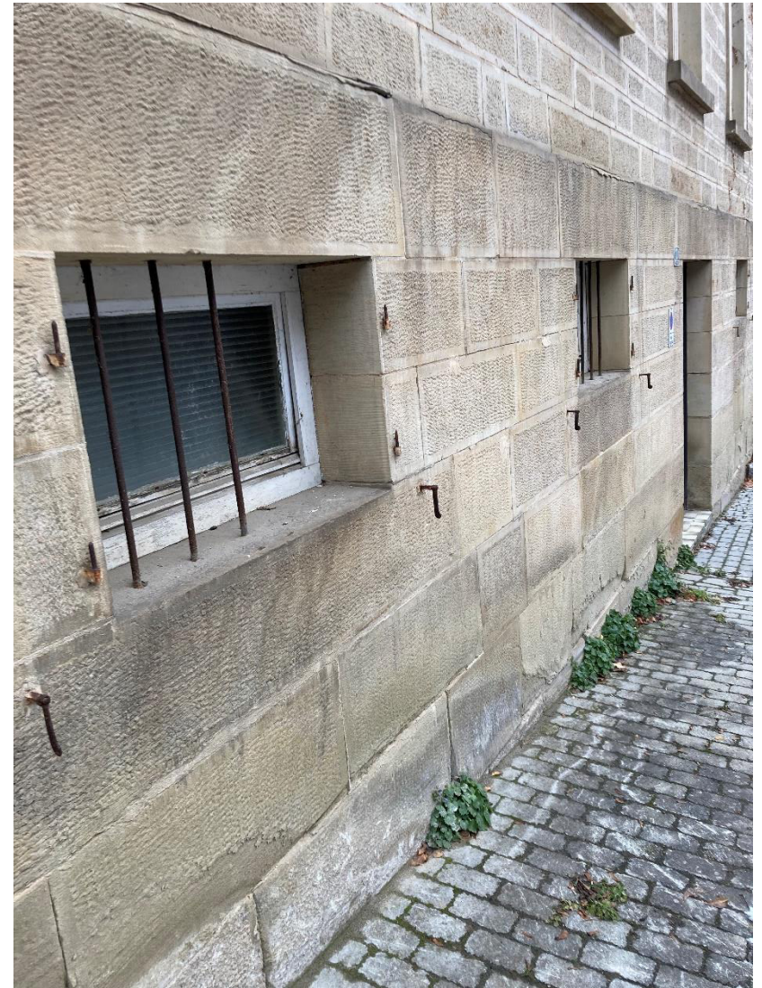
Fenster im UG
