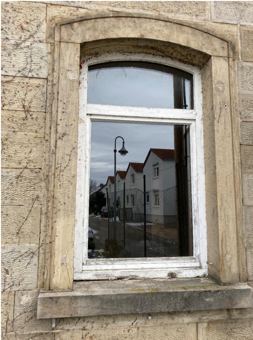
Fenster im EG
