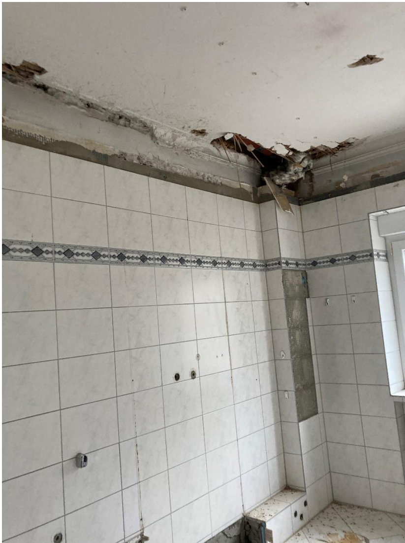
OG ehemaliges Bad
